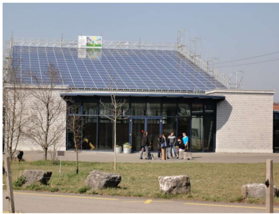
KuSpo Bruckfeld, Münchenstein, mit neuer Photovoltaikanlage
